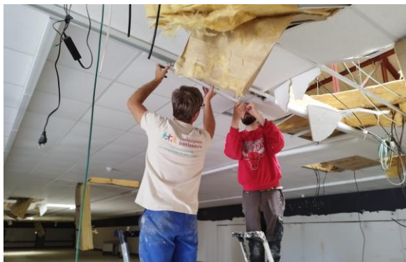
Photos de la dépose des équipements électriques par Les Compagnons Bâtisseurs
