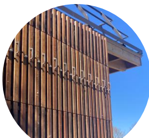
Bardage issu de menuiseries démantelées
