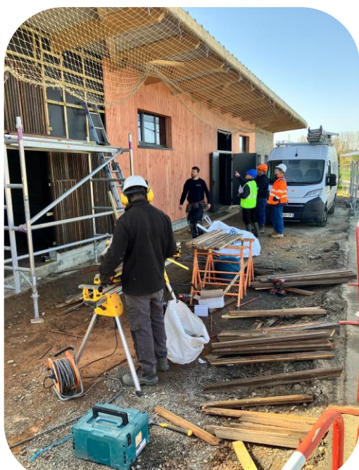
Pose du bardage bois en cours
